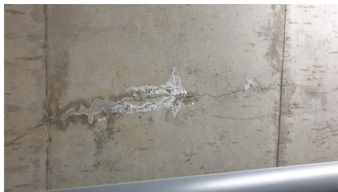
foto /11/ Detail trhliny ve stropní konstrukci (trhlina rovnoběžně s hlavní výztuží)
