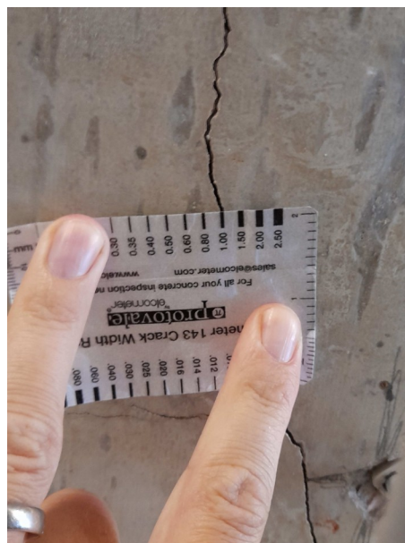
foto /15/ Trhlina na jižní opěrné stěně pod terénem (šířka 1 mm)
