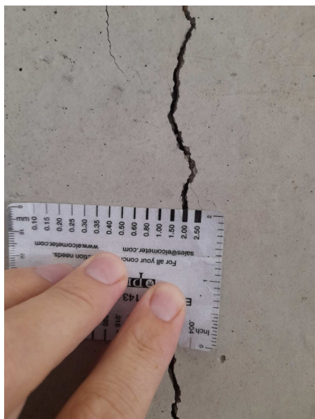
foto /14/ Trhlina na severní stěně pod oknem (šířka 2 mm)
