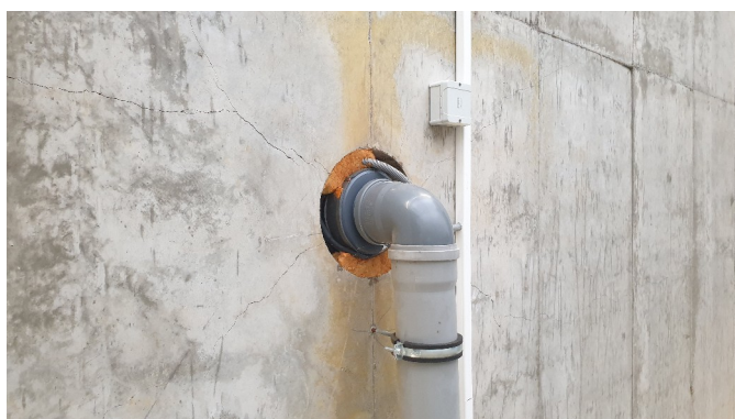
foto /12/ Trhliny kolem prostupu střešního vtoku
