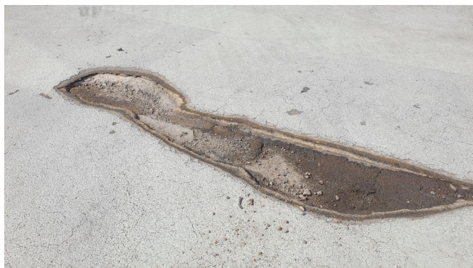
foto /6/ Porucha nad trhlínou v konstrukci
