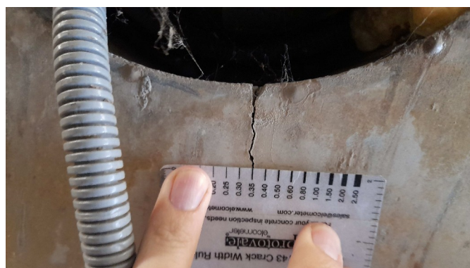
foto /13/ Detail trhliny u vtoku (šířka 0,35 mm)
