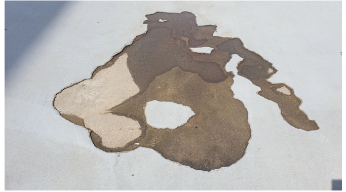
foto /8/ Porucha v ploše (bez trhliny v konstrukci)
