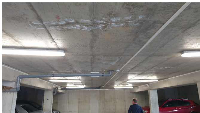
foto /10/ Trhliny ve stropní konstrukci
