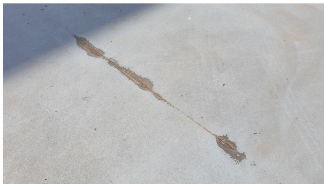
foto /4/ Ocelový profil ve vrcholu spádové vrstvy
