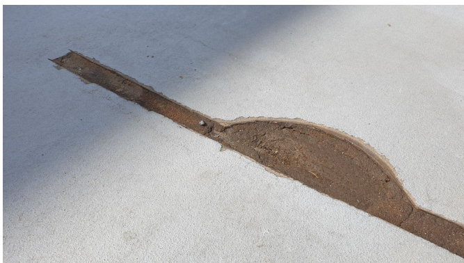
foto /5/ Vyříznutá část stěrky při neúspěšné opravě
