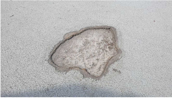
foto /7/ Porucha v ploše (bez trhliny v konstrukci)
